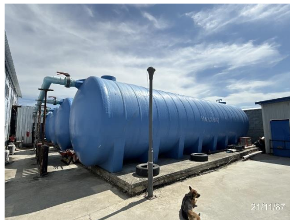
รูปที่ 2-68 : ถังเก็บน้ำใช้ (ปริมาตรรวม 400 ลูกบาศก์เมตร)
